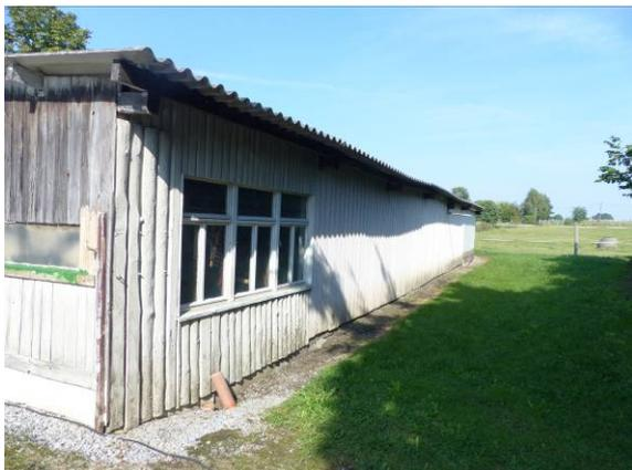
Foto 7: Schuppen aus breitfugig angebrachten Holzbrettern mit einfacher Welldachdeckung
