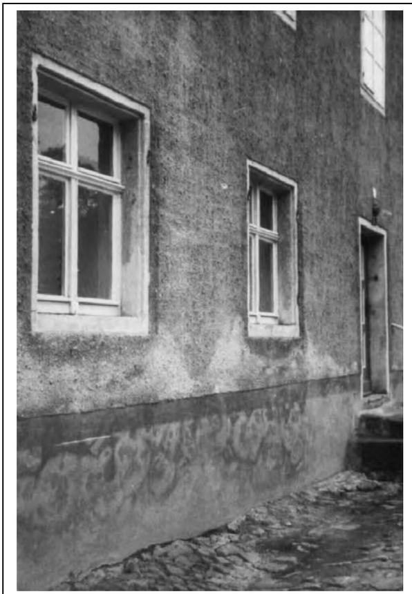
Abbildung 7 Mühlengebäude der Mittelmühle in Radeberg mit Wasserflecken vom Winter-Hochwasser 1986/87 (Quelle: privat)
