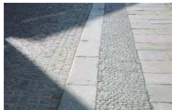
Granitpflaster und Granitplatten
