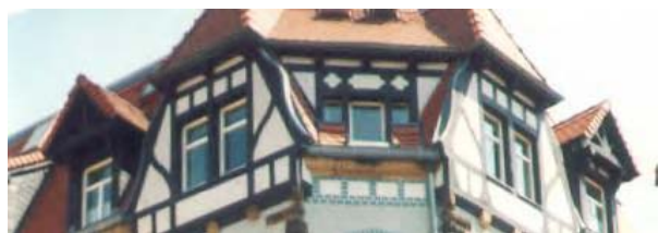
Fachwerk als Bestandteil der Fassadengliederung
