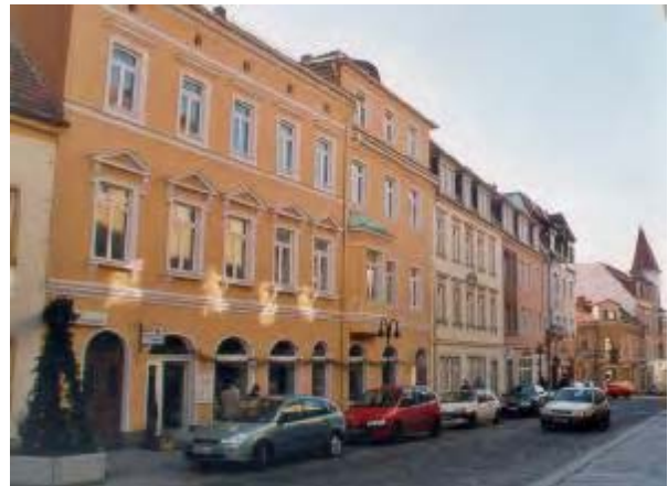
Straßenraum mit aufeinander abgestimmten Fassadenfarben, Gliederungselementen und Materialien
