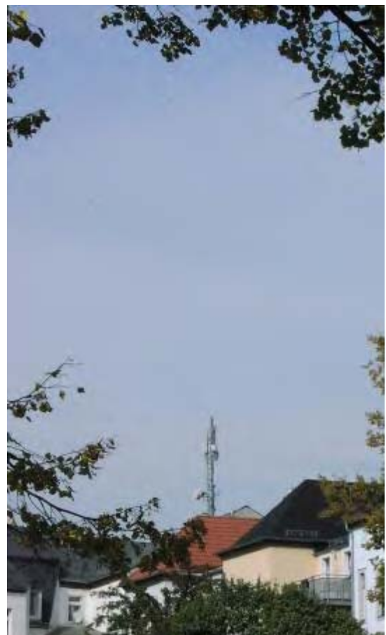
Mobilfunkanlagen können das Ortsbild beeinträchtigen
