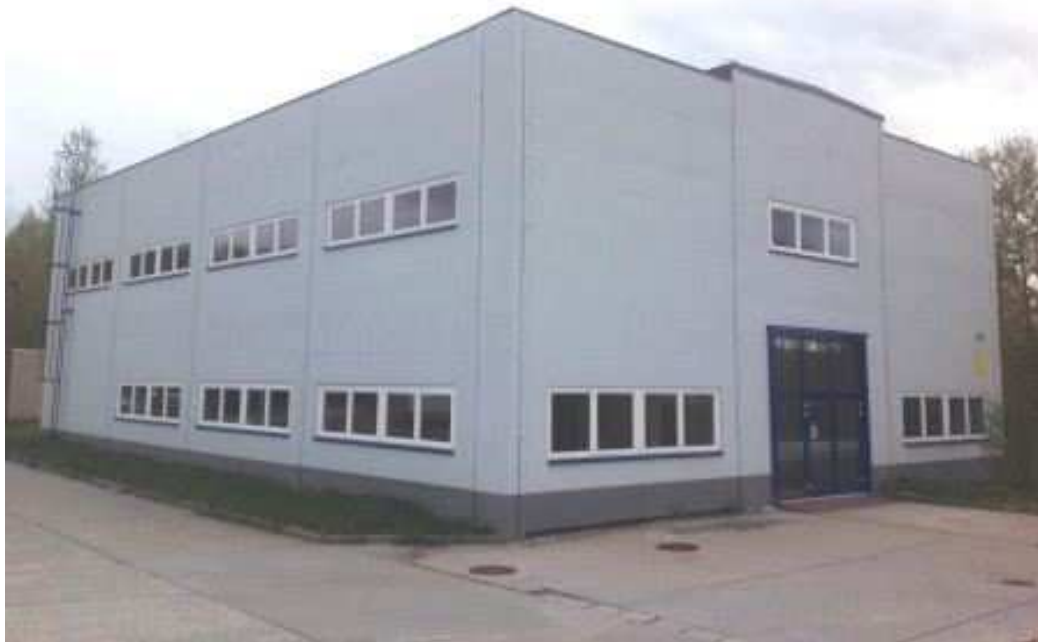
im Gebäude 956, NGF ca. 800 m 2 , davon 462 m 2 Bürofläche, 338 m 2 Nebennutzfläche
